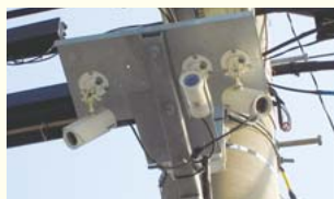
柏の葉駅周辺の電柱に設置された見守りカメラ
