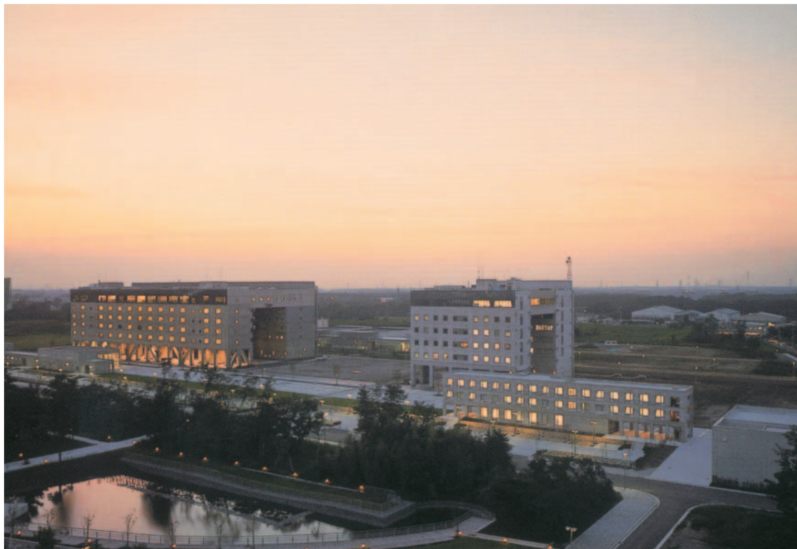
新しい時代を切り開くため、「学融合」の役割を担い建設が進められる東京大学柏キャンパス
