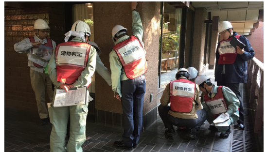
応急危険度判定訓練の様子
