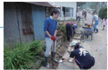
台風被害の復旧作業
