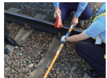
ことでん現場
