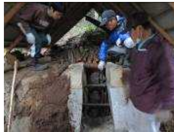
炭焼き窯の天井部分の骨格の作成
