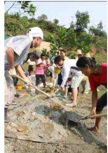
柵の土台やダムの塗装に使用する セメントを作成中
