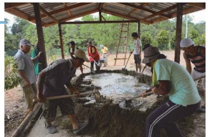
ブランコを設置する土台になるセメント作り
