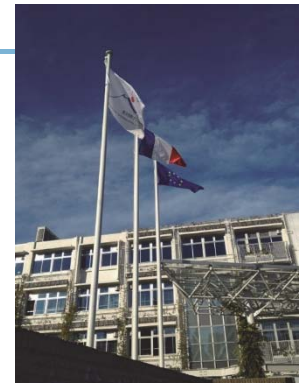
東京国際フランス学園外観
