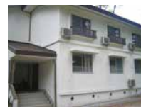
戸田寮緑線館
