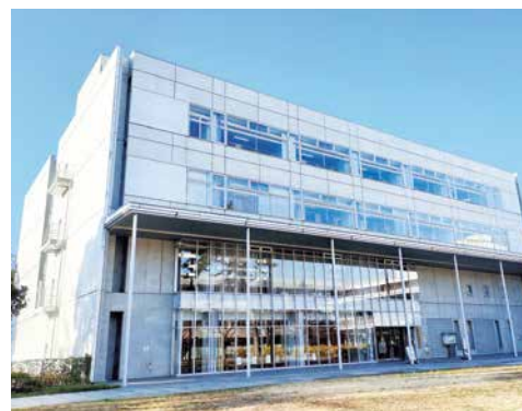
駒場図書館外観
