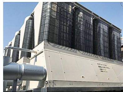
医科学研究所における熱源改修
