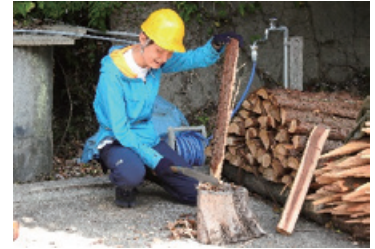
歩道の階段作りに使用する杭作り
