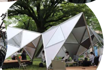
今井研究室／生研 3Dプリントを用いた セルフビルド実験建築
