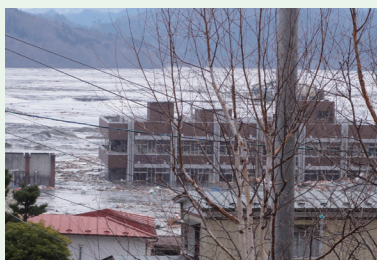
押し寄せた津波にのみれる研究棟。2階まで海水が来ています。
