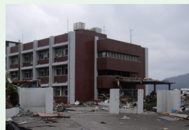
被災直後(2011年3月21日)のセンター正門付近。玄関先がれきが山積みになっています。
