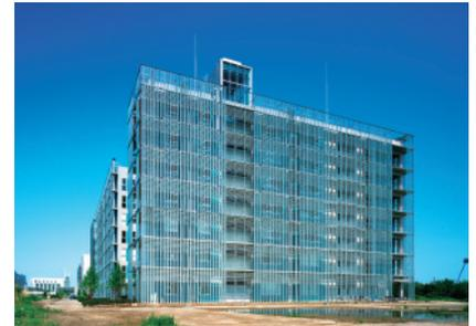
図1 環境棟西立面 西日を遮るように縦格子が使われています(写真:(株)川澄建築写真事務所)
