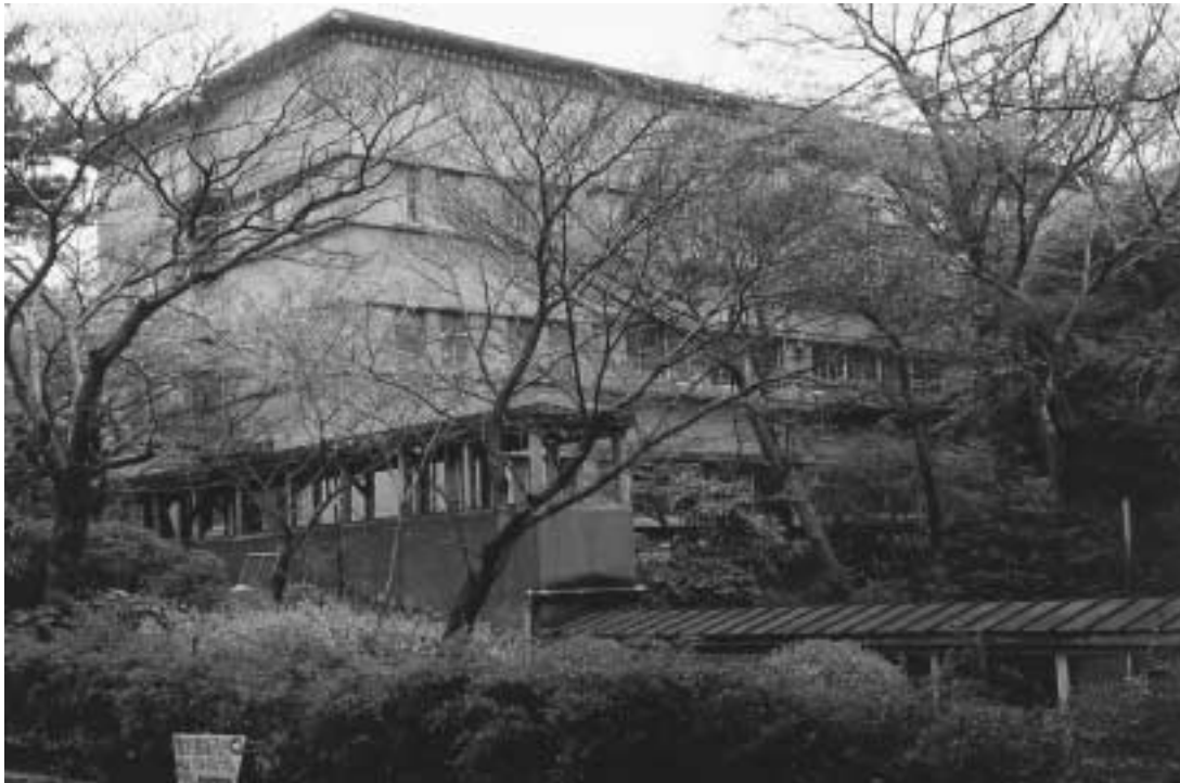
廃寮とした駒場寮
