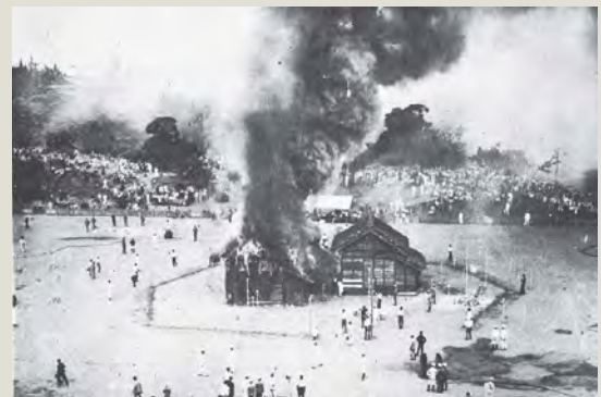
東大建築学科教室の第2回火災実験・其1(昭和9年8月25日) (写真出典：内田祥文『建築と火災』相模書房、1953年)
