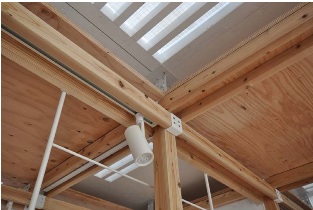
システム工法の仕口金物
