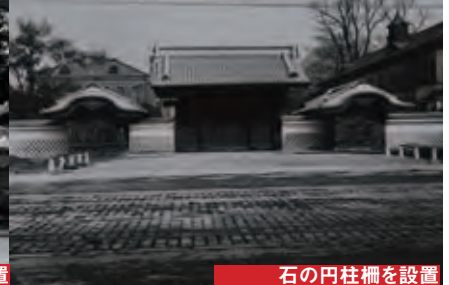
石の円柱柵を設置
