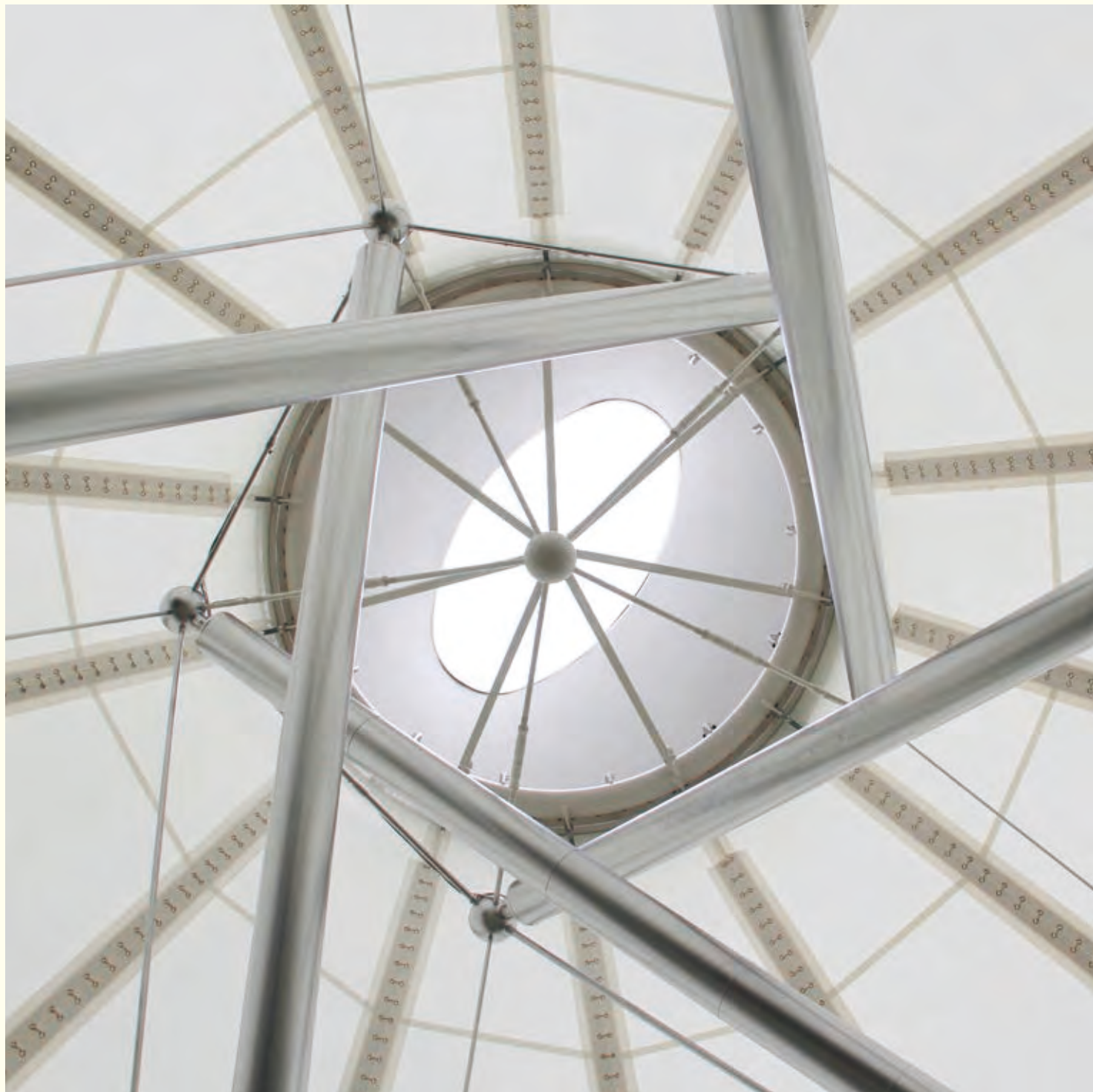
張力型空間構造モデルドーム・ホワイトライノIIの内部。
