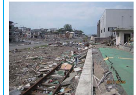
JR大船渡駅ホームから盛方向を望む 震災前（写真上）と震災後（写真下）
