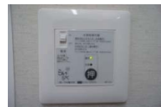
(左)復興支援のための研究・作業を行うスペース、滞在に必要な設備や貸し出し用車両を備えるTTC (下)水抜栓操作盤
