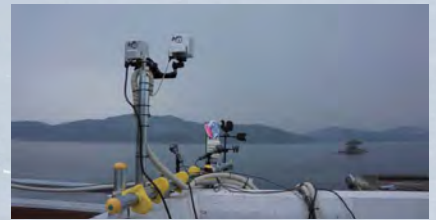
沿岸センター屋上に設置されたマイク
