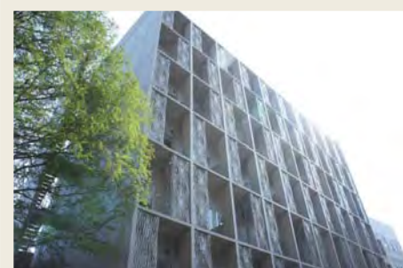
東京大学アントレプレナープラザ
