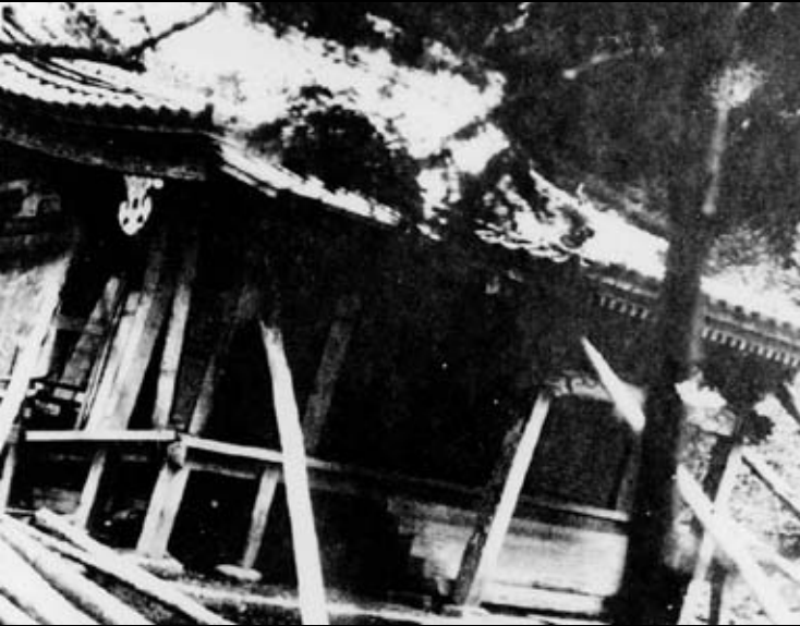
伝統木造建築には、耐震工学の理にかなった工法も見られるが、伝説化されている部分も多々ある
