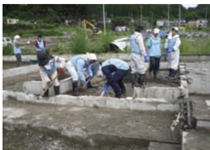
住宅のがれき撤去作業の様子
