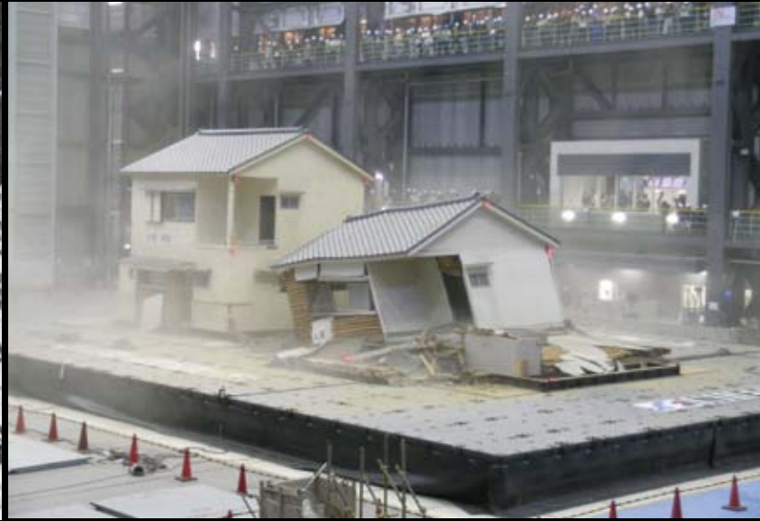
耐震補強を行った木造住宅（左）と耐震補強を行っていない木造住宅（右）の大地震加振後。耐震補強を行った木造住宅は倒壊を免れ、中にいる人の命を守ることができる
