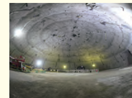
完成した本体空洞ドーム部（直径69m、高さ21m）。
