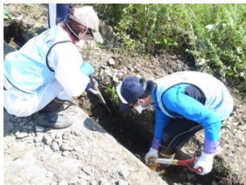
被災地区での側溝の土出し(1)
