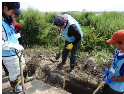
被災地区での側溝の土出し(2)
