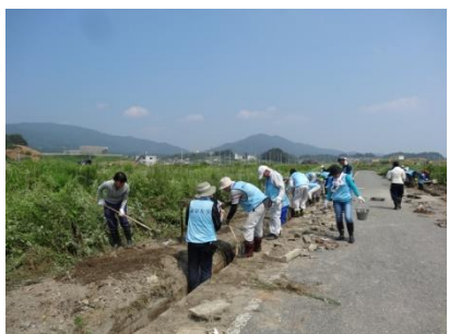
被災地区での側溝の土出し(1)
