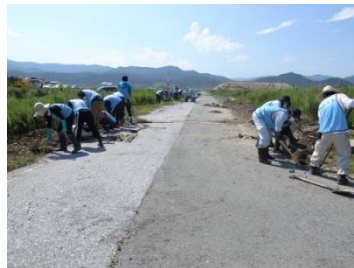
被災地区での側溝の土出し(2)
