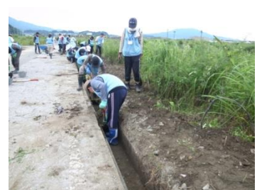
側溝がきれいになった
