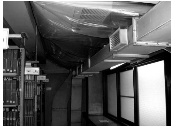
医学部総合中央館（図書館）書庫天井仮養生写真
