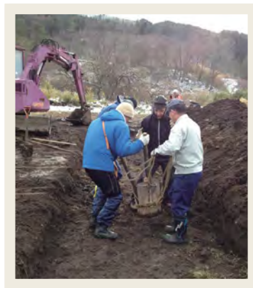
「までい工法」で穴に表土を埋めて固める作業の様子（2012年12月）。『美輪明宏がヨイトマケ歌うらしい』なんて話をしながらみんなで作業しました（溝口教授）
