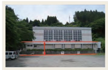
沿岸センター再建予定地の赤浜地区では、こんなに高く(6m以上)盛土する計画になっている。
