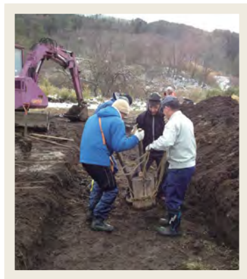
「までい工法」で穴に表土を埋めて固める作業の様子(2012年12月)。「美輪明宏がヨイトマケ歌うらしい」なんて話をしながらみんなで作業しました(溝口教授)
