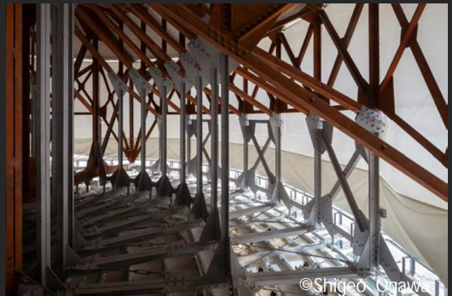
2014年改修工事竣工時の補強鉄骨取付状況
