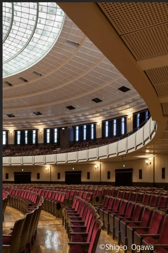
2014年改修工事竣工時の講堂床の状況
