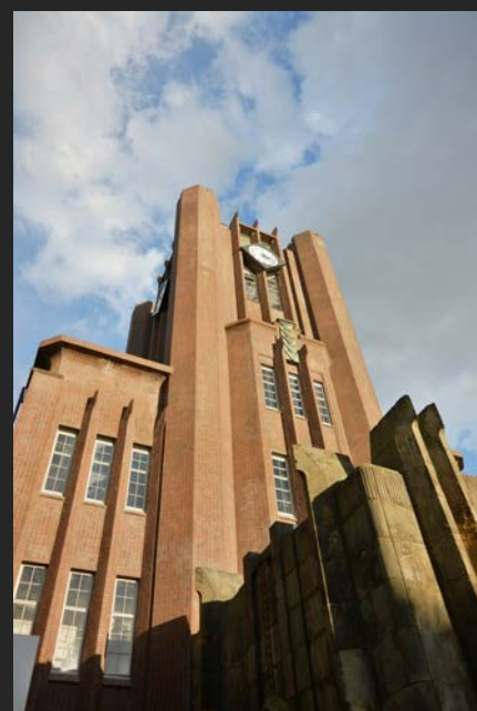
2014年改修工事竣工時の状況
