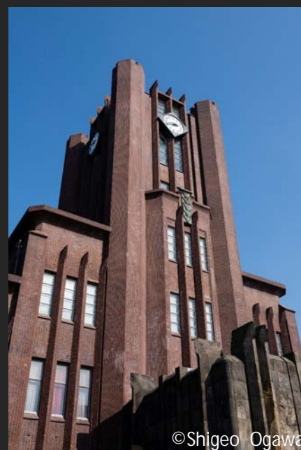
©Shigeo Ogawa 2014年改修工事 改修前の状況
