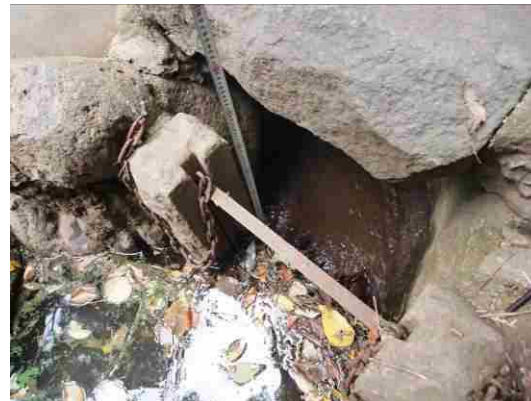
写真 4-10 排水溝の水位計測
