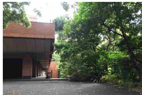
写真 1-2 山上会館エントランスとテラス
