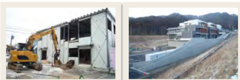
(左)解体工事が進む遠野東大センター(2018.3.8現在)。(右)大気海洋研究所附属国際沿岸海洋研究センター新棟(大槌町)。
