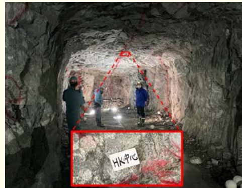
2020年7月、ハイパーカミオカンデの建設予定地に調査トンネルが到達した。ここに70メートルスケールの世界最大規模の大空洞を掘る予定。
