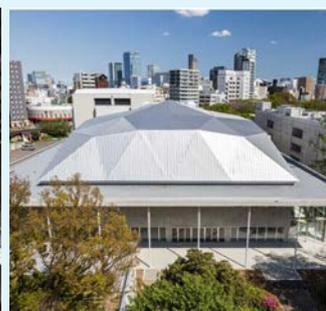
(左) アリーナ内部から見た屋根と横長の採光窓。(右) KOMCEEから見た第2体育館のドーム屋根。フッ素ガルバリウム鋼板t=0.4縦ハゼ葺きです。
