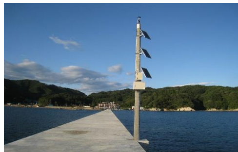
〔写真 12〕 大槌湾海洋環境モニタリングリアル タイム中継の開始 (H26.9.5) (風向・風速計の設置)
