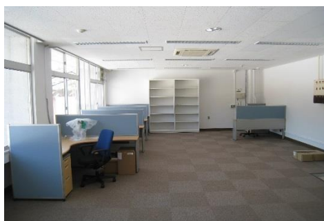
〔写真 14〕 センター3階 (教員室) 改修工事完成 (H26.2.25)
