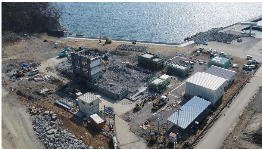
〔写真 20〕 旧センター建物解体及び実験水槽棟等新営工事（H31.2.27）
