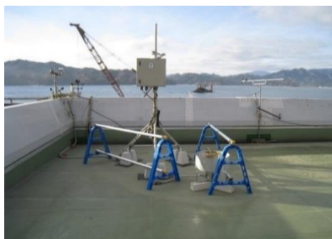
〔写真 11〕 研究機器等の復旧 (H25.12.6) (気温計・湿度計・雨量計設置)
