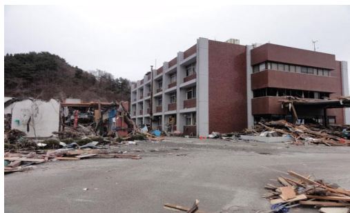
〔写真 1〕 センター被災直後の外観（H23.3.15）
