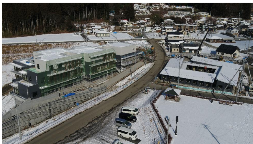
〔写真 17〕 中央道路を挟んで左側が研究実験棟、右側が宿泊棟(H30. 2. 26)
