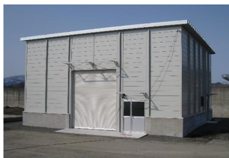
〔写真 15〕 プレハブ倉庫完成 (H26.2.28)
