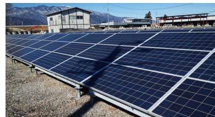
▲故障を検知・修理し、発電性能が回復した山梨県内の発電所
