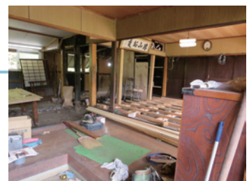
空き家の床板張り
