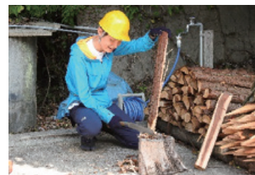
歩道の階段作りに使用する杭作り
