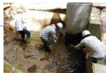
計測作業の一部
