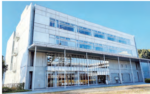
駒場図書館外観
