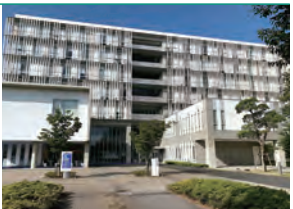
大気海洋研究棟
