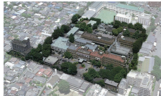
上空から見た目白台病院分院
