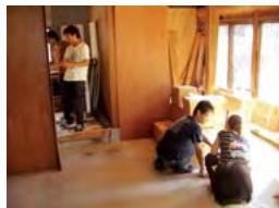
店舗内装作業の様子
