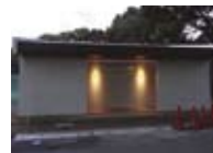
駒場のテニスコート横トイレを改装
