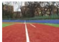
東大球場のめくれた人工芝を改装
