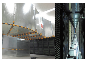
図1：左の写真はスパコン「Shirokane3」の外観。室内は空気の移動のためのダクトが目立っています。右の写真は100Pバイトまでデータを蓄えることができるテープ装置です。
