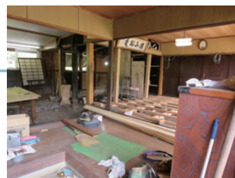
空き家の床板張り
