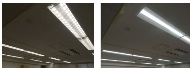
図1 Hf蛍光灯のLED化（左：更新前のHf蛍光灯、右：更新後のLED照明）
