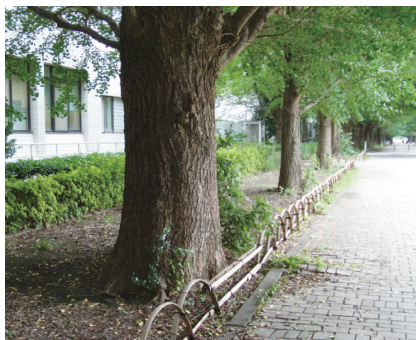
図 2 銀杏並木に設置された竹柵 モウソウダケの竹ヒゴをアーチ状に曲げて作られた。水平の長い竹ヒゴは、アーチを繋げて柵を安定化するとともに落ち葉止めとしても役立つ。
