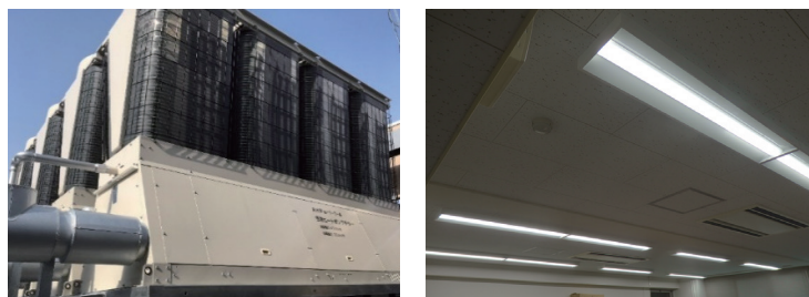
図3 省エネの設備更新対策 左：大型空調熱源設備の更新後、右：Hf照明のLED化後
